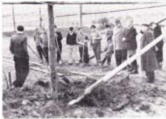
1954 erster Spatenstich an der Sporthalle
